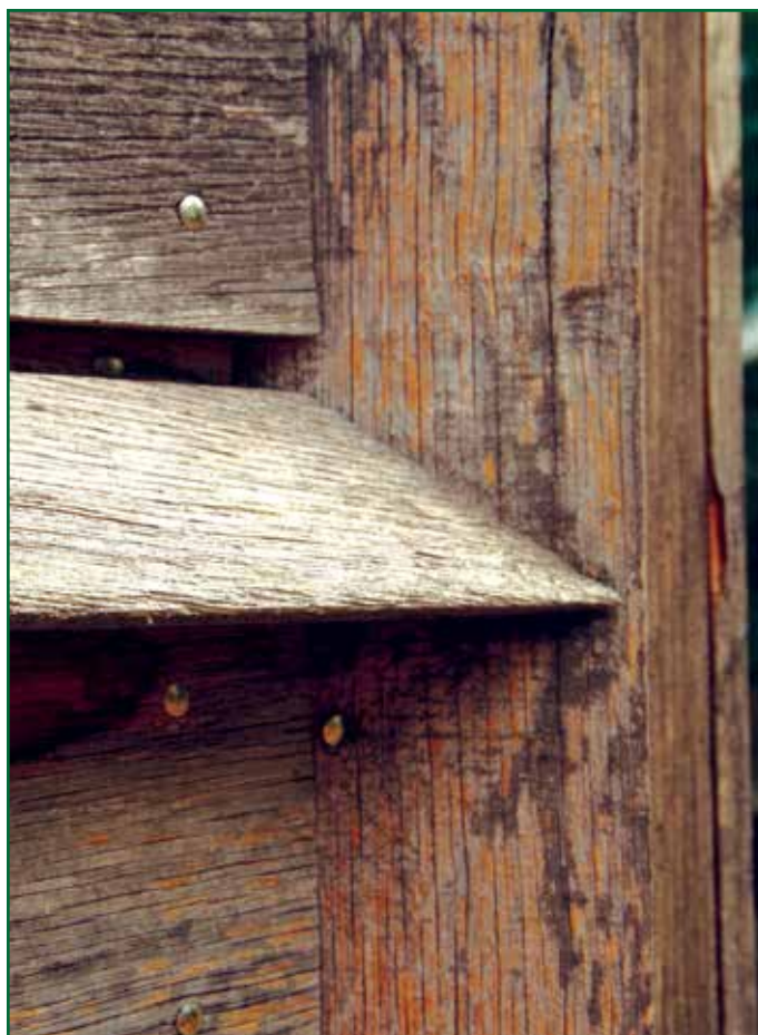
DETALJER: Nøyaktige skjøter og andre tilpasninger preger bygget. Syrefast spiker eller skruer er en forutsetning for eik.
