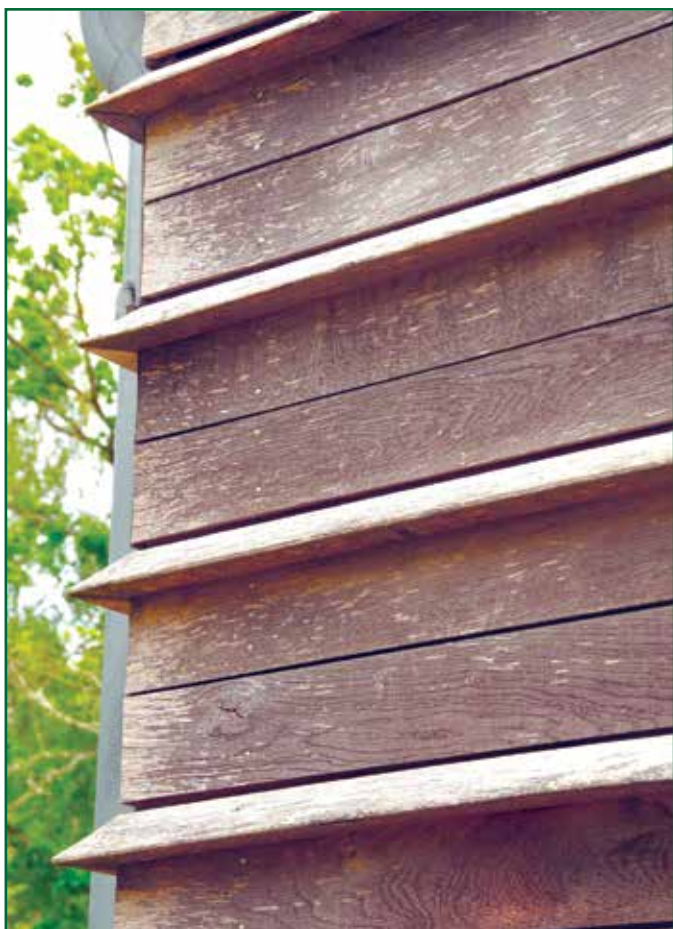
TO BORD: To smale bord er satt sammen mellom lister med skråprofil.
